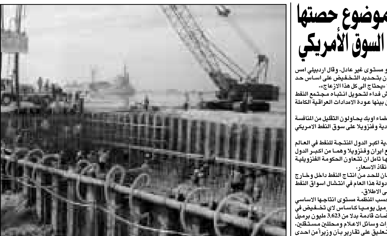
عمال يعملون على مقطع من جسر ضخم يجري بناءه حالياً فوق قناة السويس
