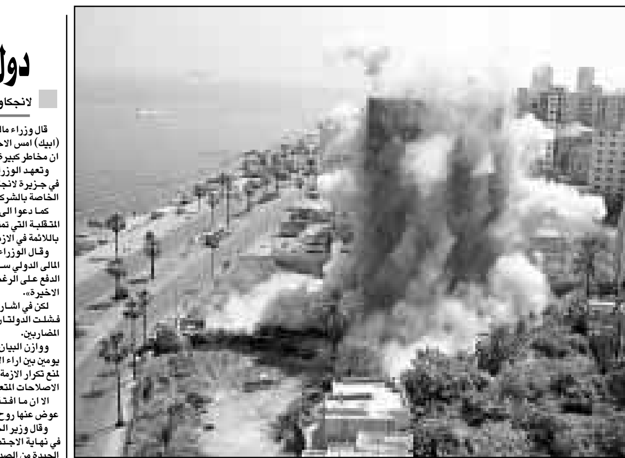
موجة من العبار الكثيف تلف مبنى فندق الشيراتون المطل على واجهة بيروت البحرية لدى تفجيره أمس الأحد لاعادة بنائه من جديد. وكانت السلطات اللبنانية قد حظرت استعمال الفندق الذي بني عام 1979 لأنه غير آمن من الناحية الهندسية (رويترز)
