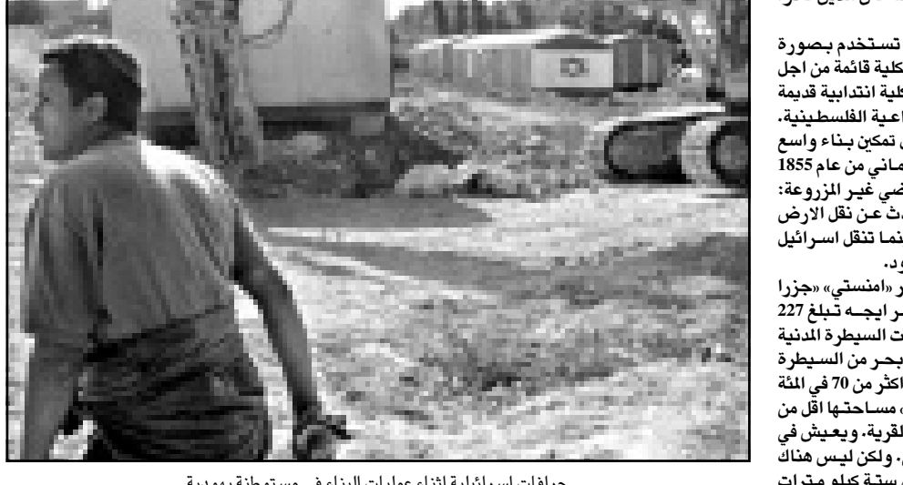
جرافات اسرائيلية اثناء عمليات البناء في مستوطنة يهودية
