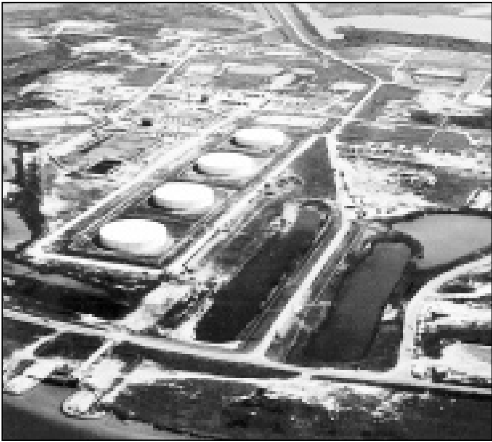
صورة جوية لخزانات برلين ماوند وهي احد اربعة مواقع كبرى لتخزين الاحتياطي الاستراتيجي للنفط الامريكي (اف ب)
