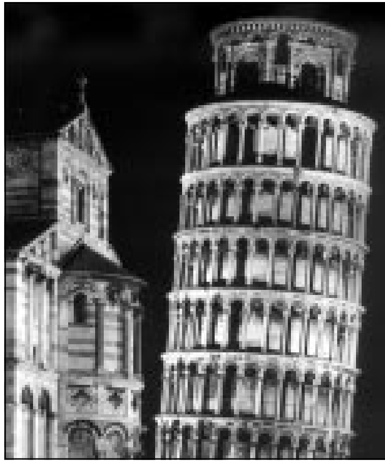
برج بيزا المائل في أوساط إيطاليا، إلى جانب باليكا الدومو، يوم واحد من افتتاحه الرسمي بانتهاه أعمال الترميم في 15 حزيران (يونيو) الماضي. وكانت أعمال تجليس البرج الشهير قد بدأت قبل عشر سنوات عندما مال بمقدار 6 درجات أو 13 قدماً من رأس الزاوية القائمة في ناحته الجنوبية. وشطط كمية من التراب من قاعدته واستعمال كلابات فولانية «ملاقات»، خلال أعمال الصخر أصبح البرج أكثر استقراراً وتراجعت ميلانه 16 بوصة حتى أصبح قريباً من الميلاء الذي كان عليه قبل 300 سنة.
