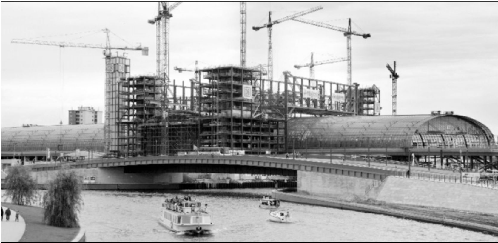
صورة بانورامية للمحطة خلال عملية البناء
