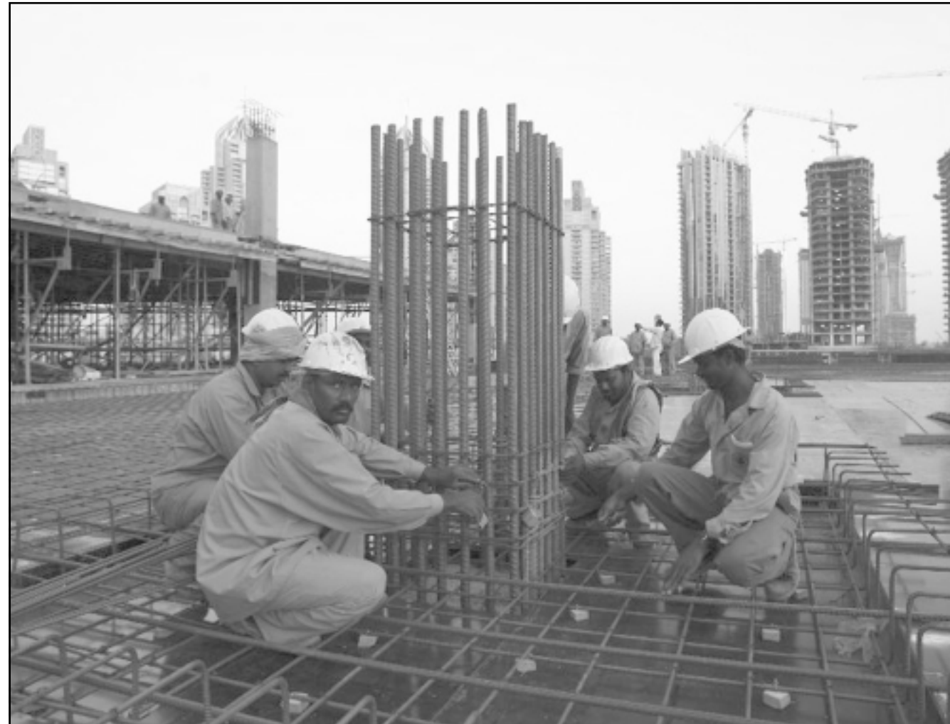
عمال بناء في دبي حيث تتسارع عمليات انشاء مشاريع اسكانية لمواجهة نمو سكاني كبير متوقع
