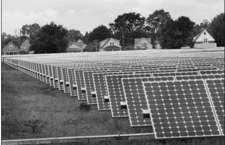
الواح ضوئية بمحطة اكسلون لتوليد الكهرباء من الطاقة الشمسية في جنوب شيكاغو. هذه المحطة هي الأكبر من نوعها في الولايات المتحدة بقدرة 10 ميغا وات
