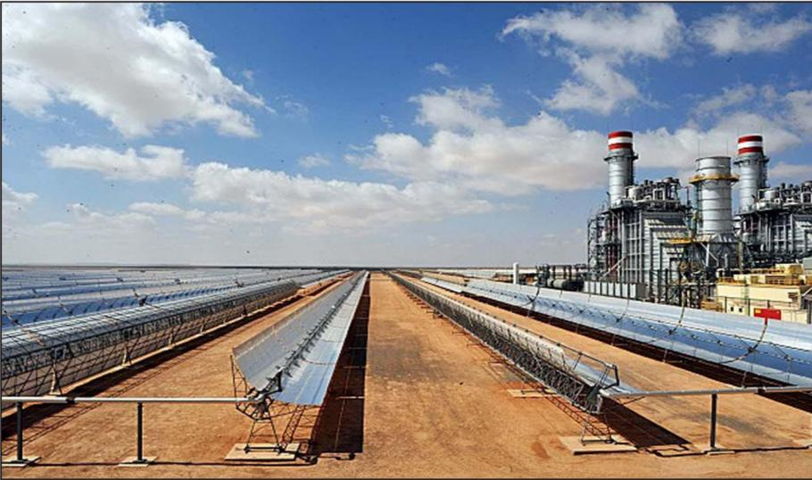
محطة ورزازات لتحويل ضوء الشمس الى حرارة لتوليد البخار الذي يدير مولدات الكهرباء
