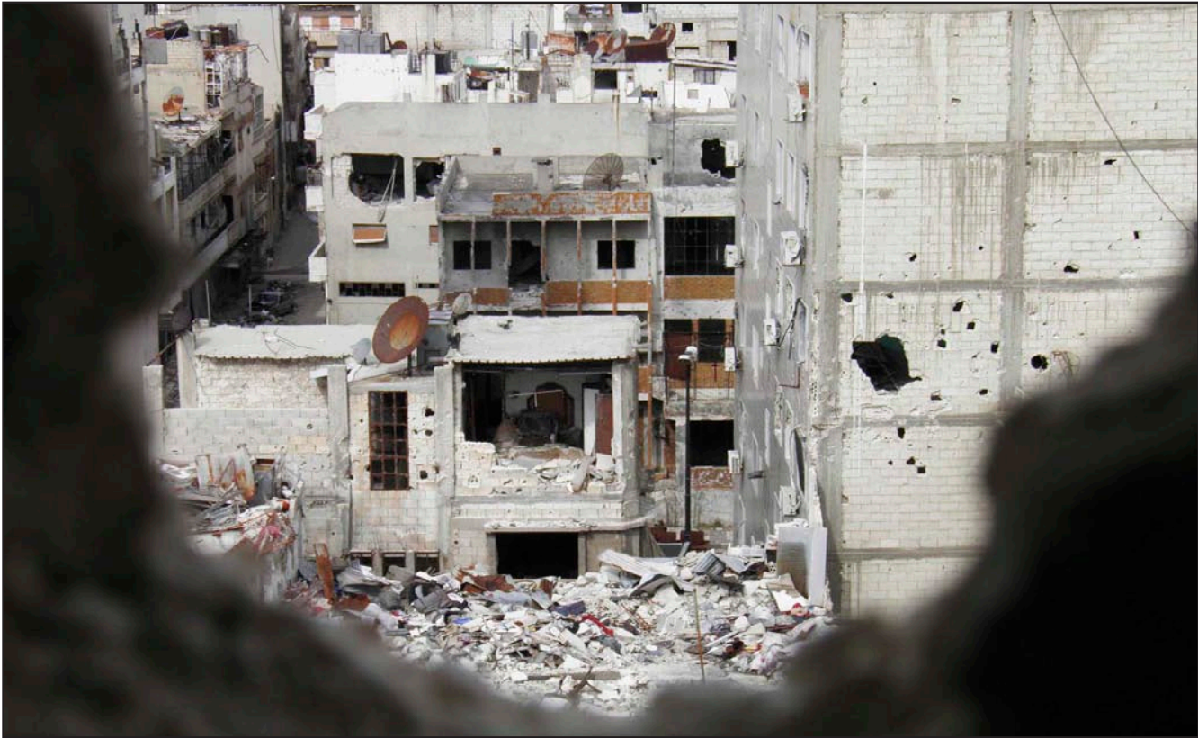
بنايات مدمرة جراء القصف في حمص
