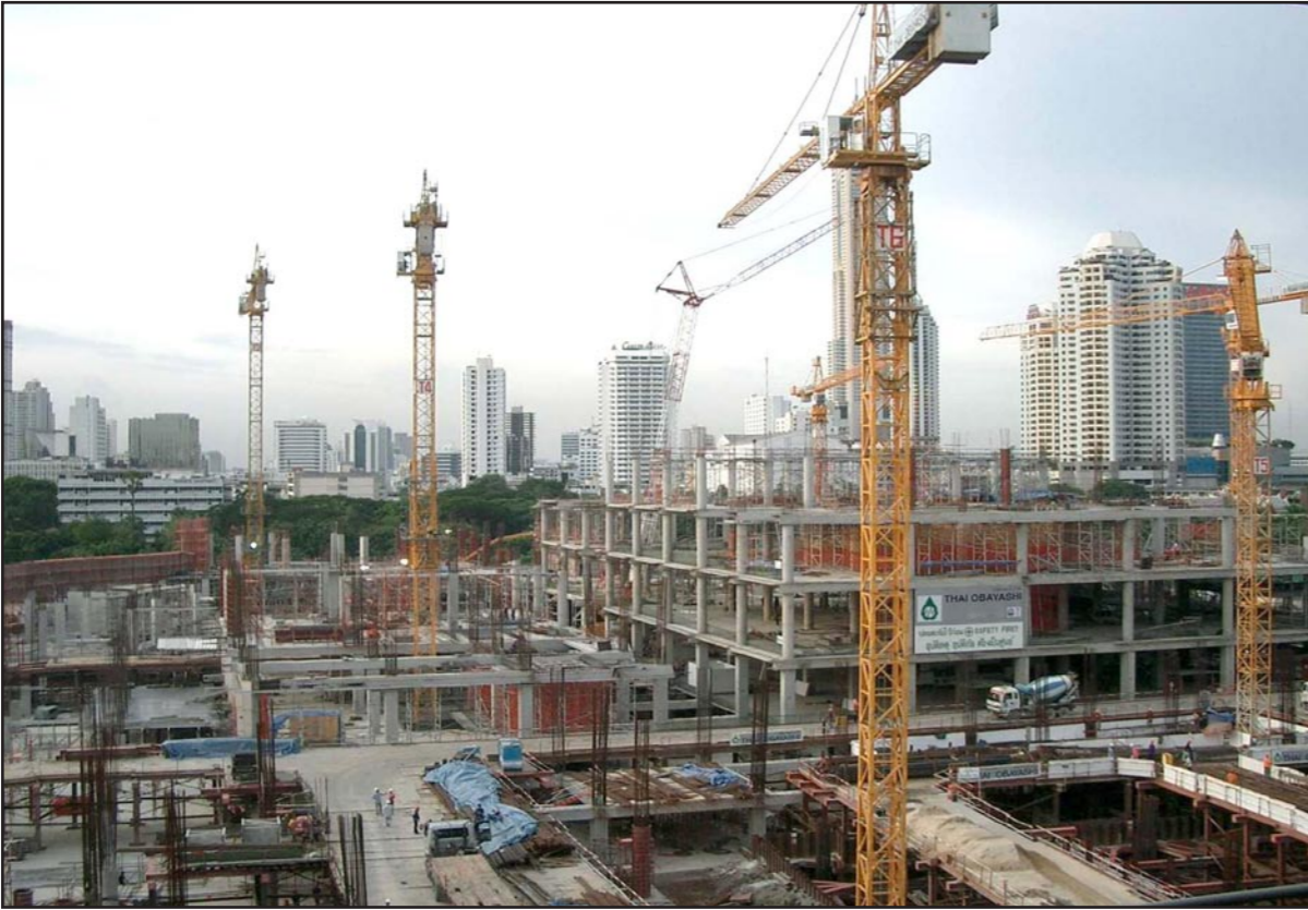
واحدة من مئات ورشات البناء في الامارات
