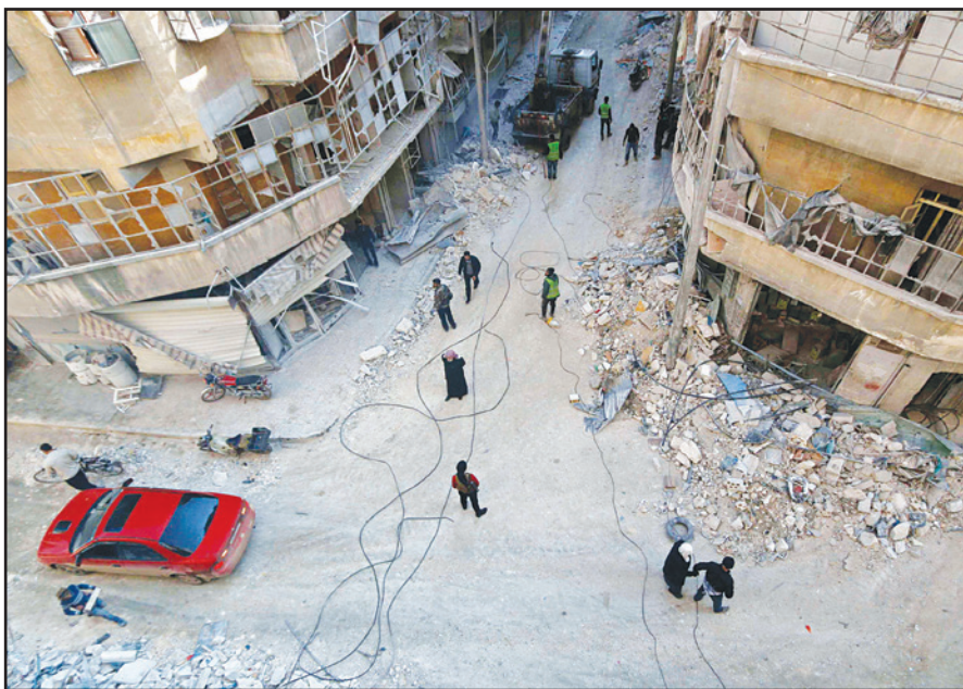
عمال يصلحون شبكة الكهرباء قرب أبنية متضررة بفعل غارات بالبراميل المتفجرة في منطقة الشعار بحلب
