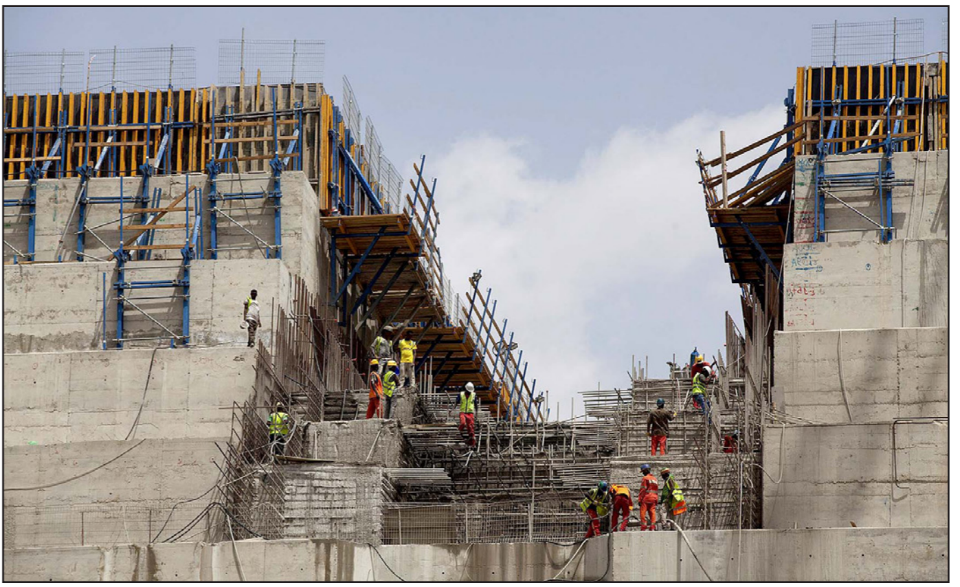
اعمال البناء على قدم وساق في سد النهضة الإثيوبي
