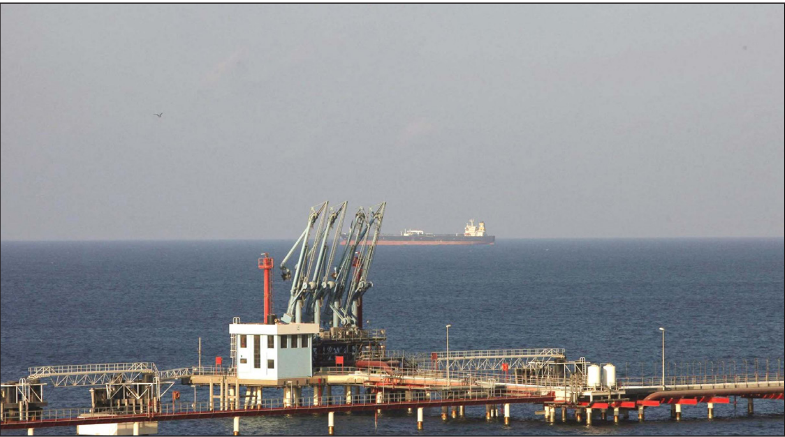
رصيف تحميل نفطي في ميناء الحريقة في شرق ليبيا
