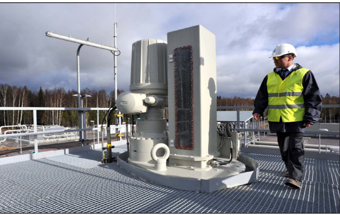
جانب من محطة لتلقيح الغاز في روسيا عند بداية المقطع البحري له «نوردستريم»
