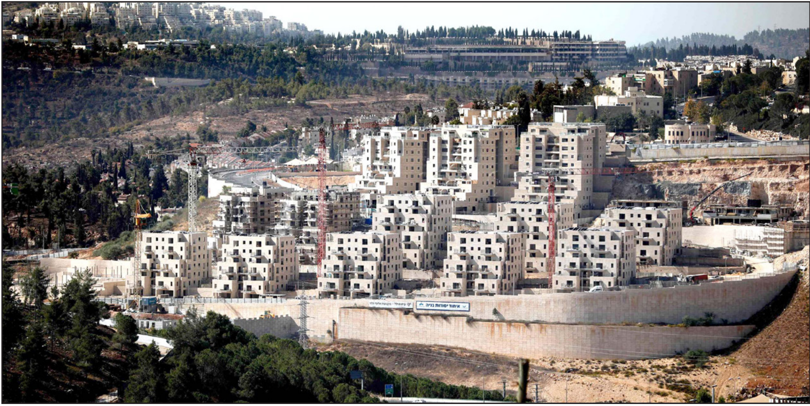
أعمال البناء جارية في مستوطنة «راموت»
