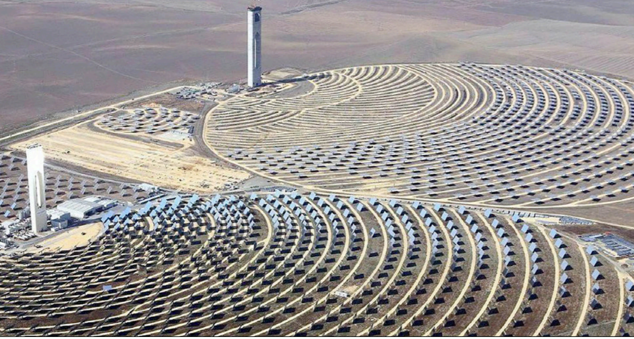
رسم تخطيطي لمحطة طاقة شمسية في نطاق مشروع لاستغلال وإنتاج للطاقة الشمسية في العالم
