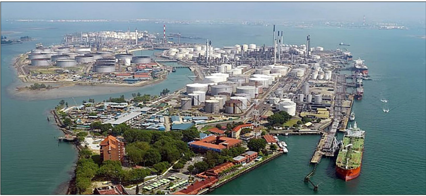
إحدى منشآت تخزين النفط في سنغافورا
