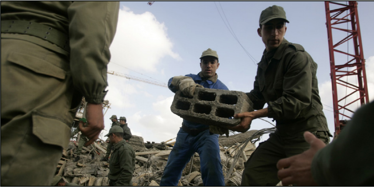
جنود مغاربة يقومون بإزالة ركام إحدى البنايات المتهدمة
