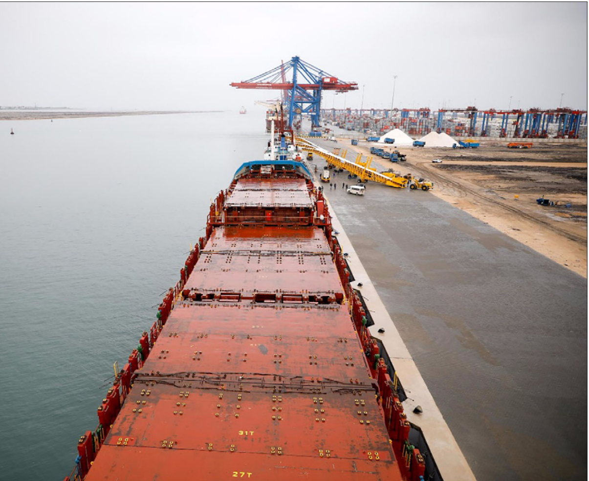
أحد أرصفة ميناء شرق بورسعيد
