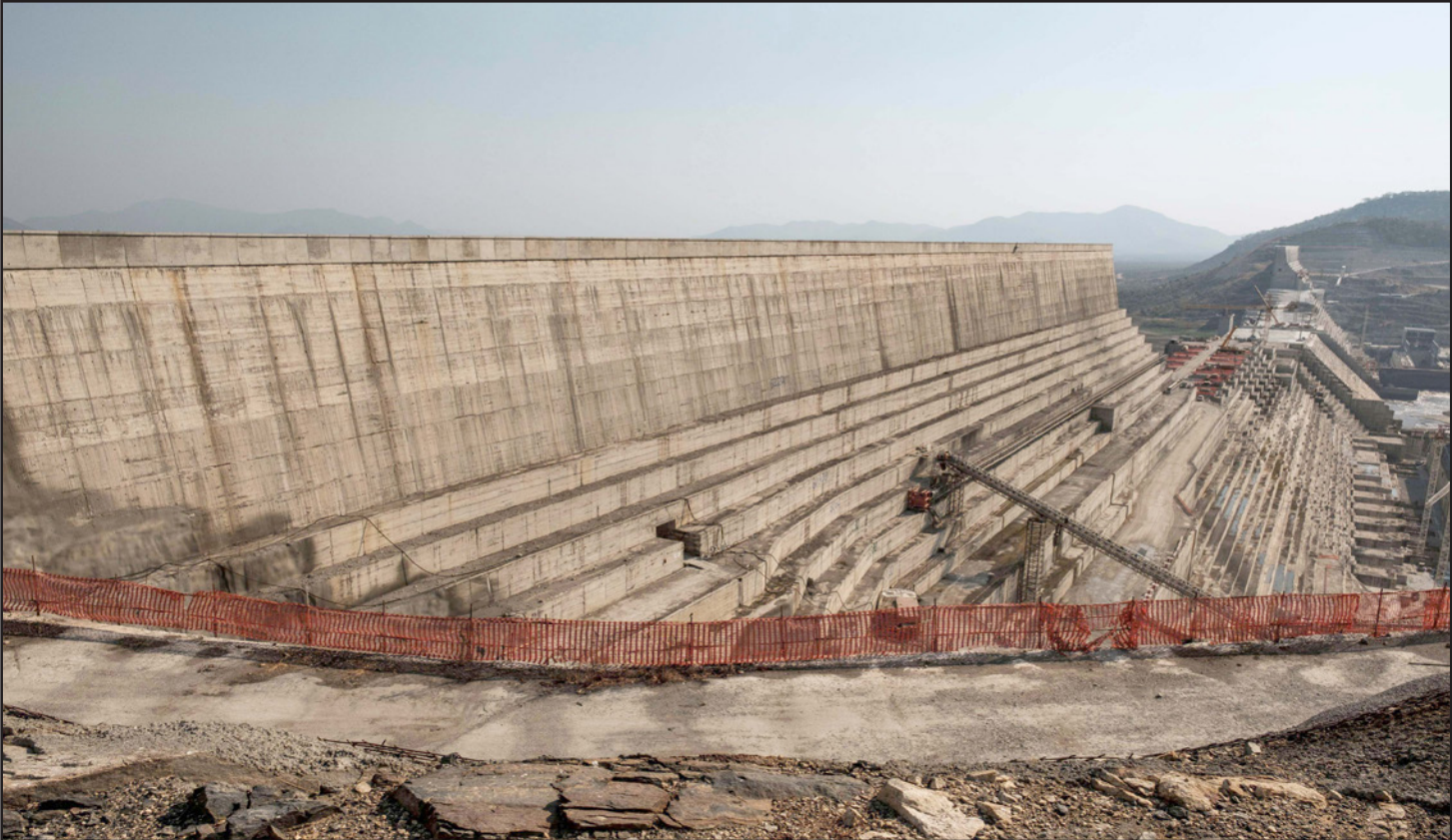
من أعمال بناء سد النهضة
