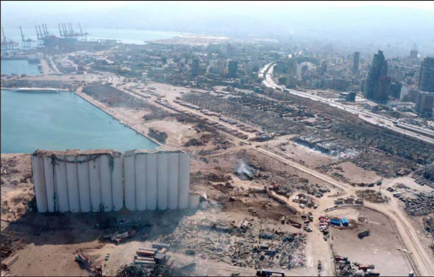
صورة من الجو توضح حجم الدمار الذي ضرب ميناء بيروت جراء الانفجار
