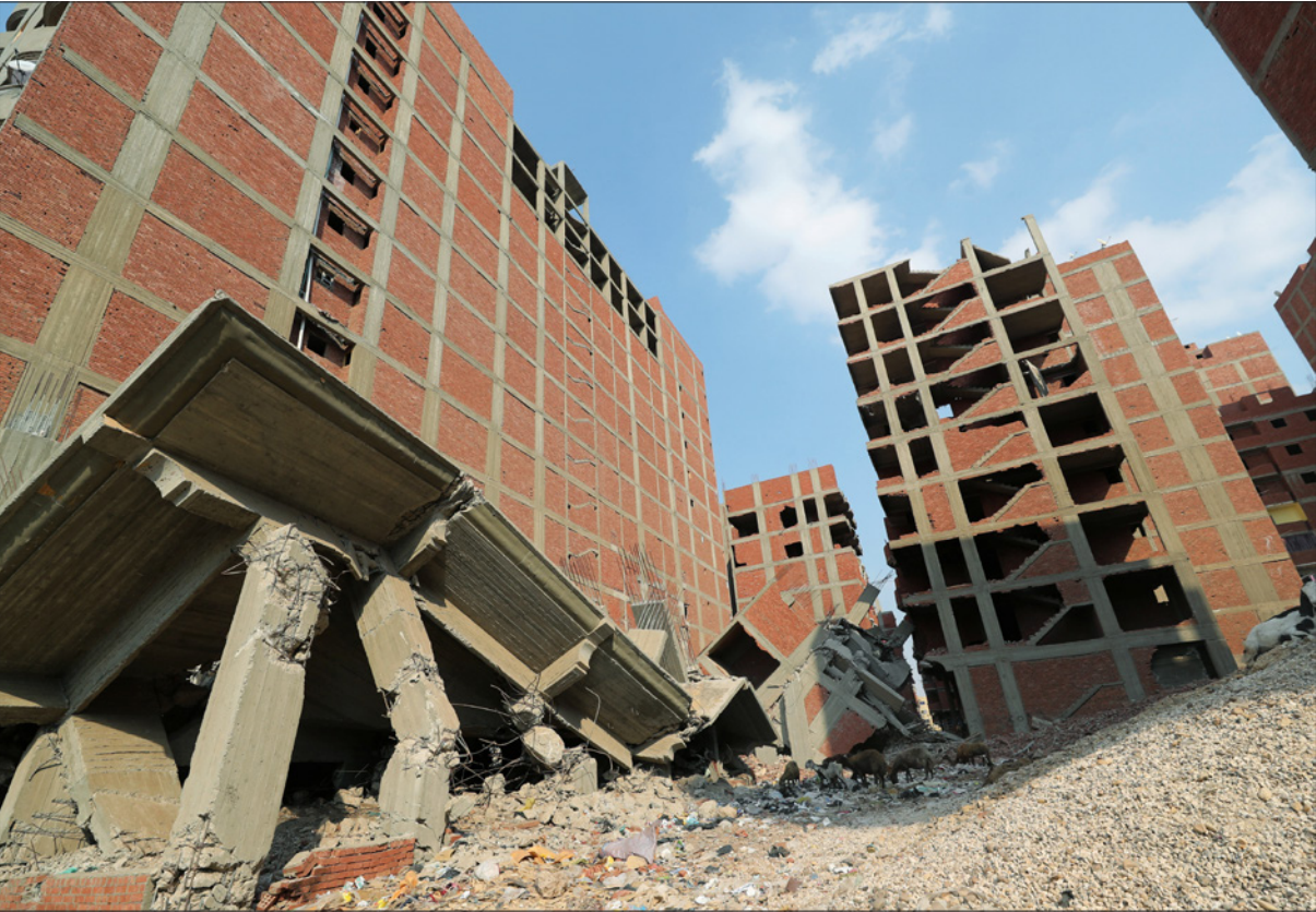
عمارة من عدة طوابق قيد الهدم في مدينة الخصوص في محافظة القليوبية
