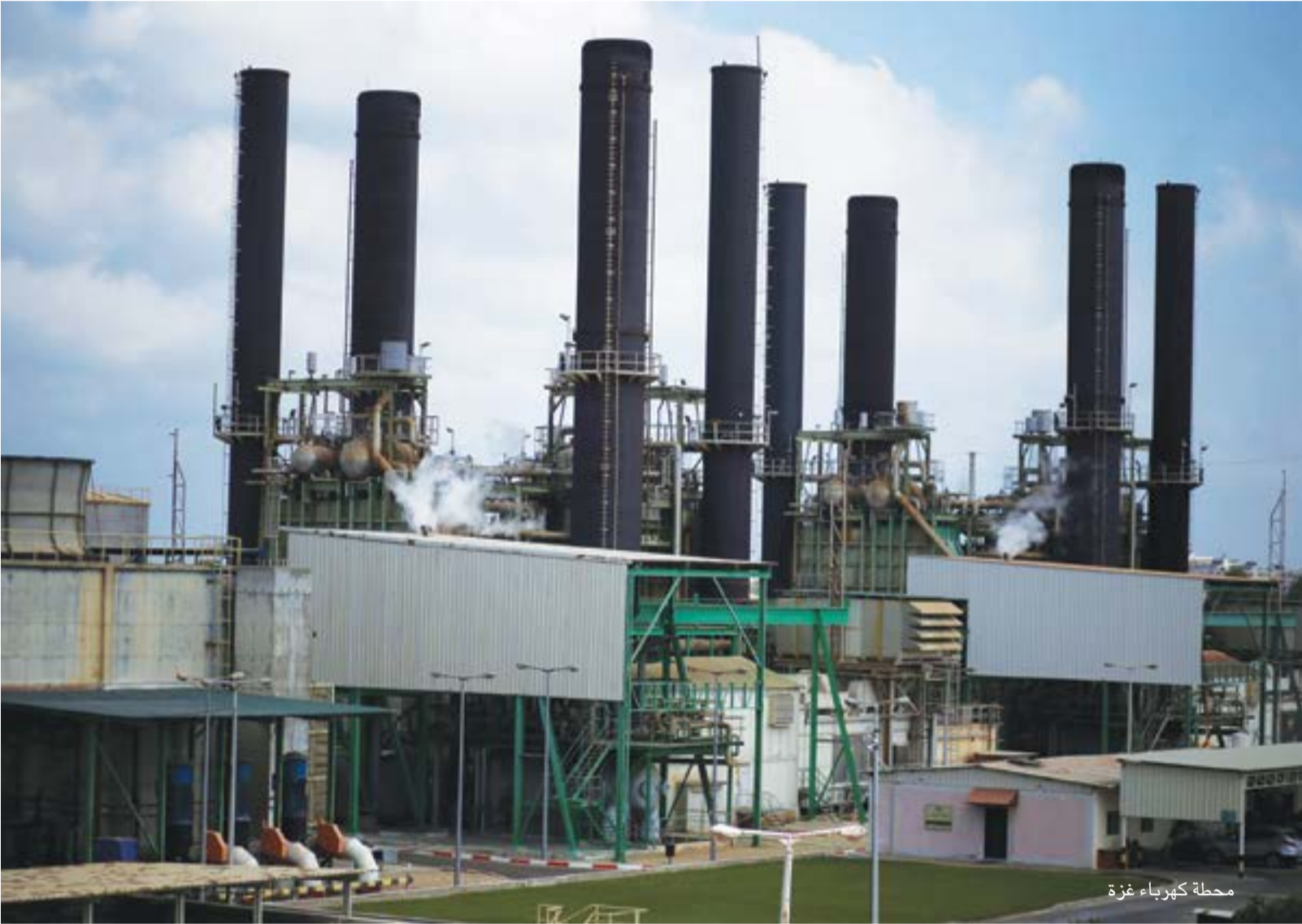
محطة كهرباء غزة
