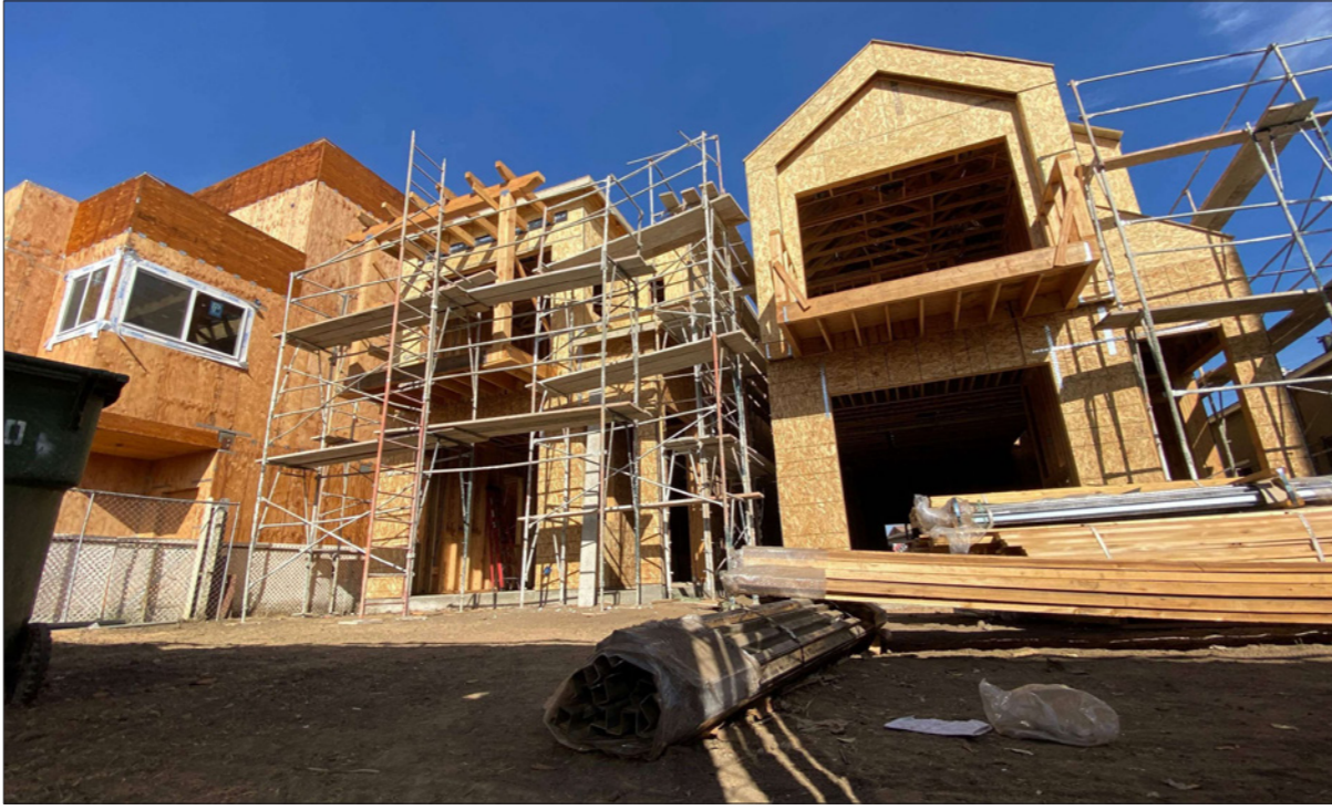
منازل جديدة قيد الإنشاء في إحدى ضواحي لوس أنجلوس
