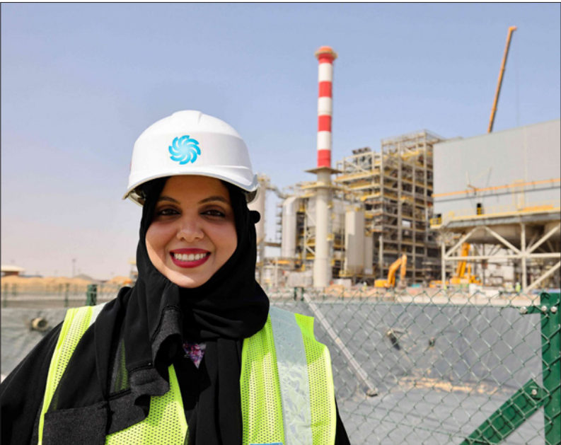
المهندسة عالية النقبى أمام منشأة معالجة نفايات في الشارقة قيد البناء تابعة لشركة «البيئة»
