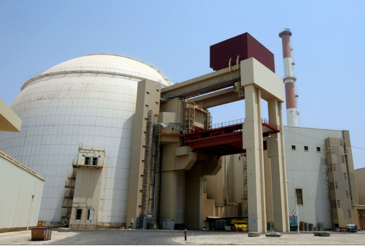
مبنى مفاعل محطة بوشهر للطاقة النووية التي شيدتها روسيا في جنوب إيران
