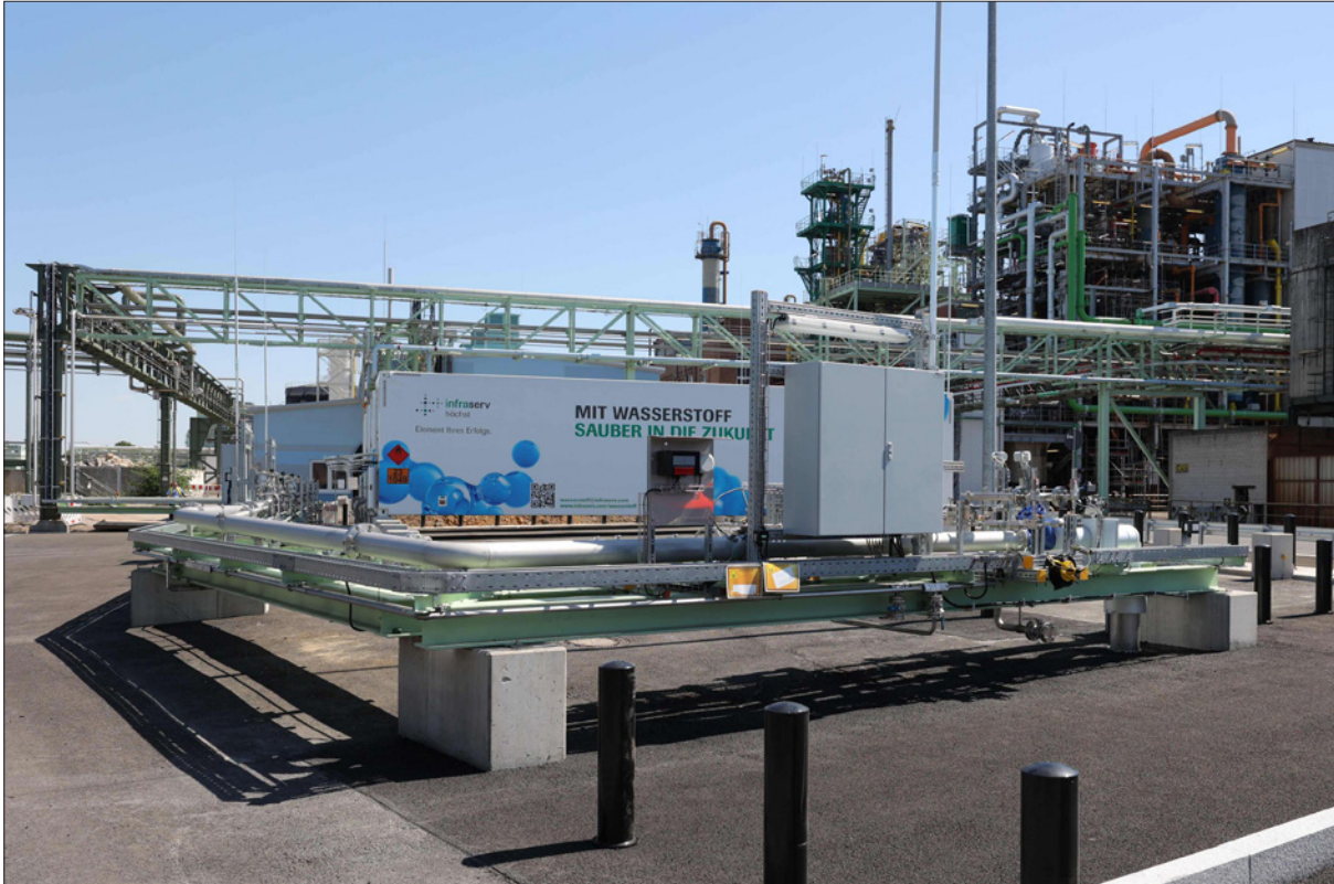
جانب من محطة لتزويد قطارات الركاب بوقود الهيدروجين المسال قرب مدينة فرانكفورت الألمانية
