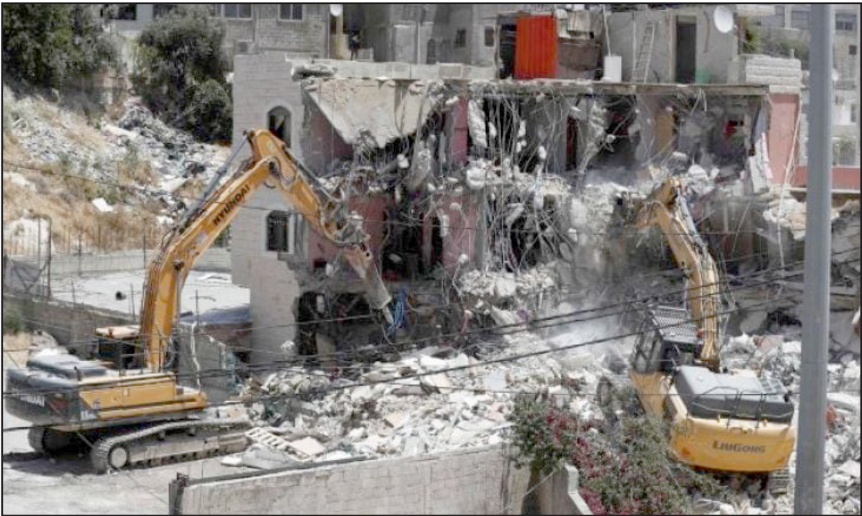
قوات الاحتلال تهدم إحدى البنايات الفلسطينية في الضفة
