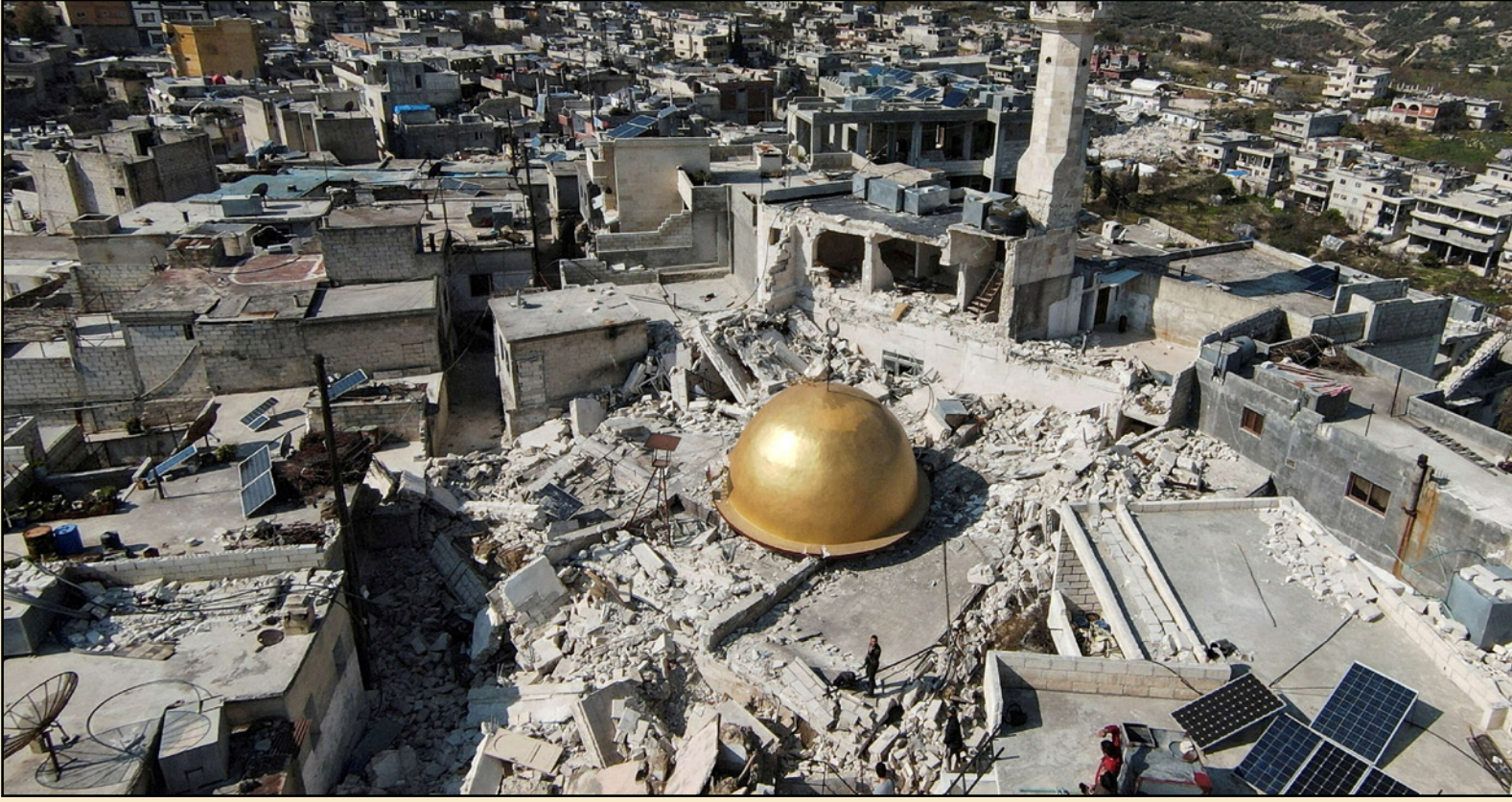
مسجد مدمر نتيجة الزلزال في إدلب شمال غرب سوريا
