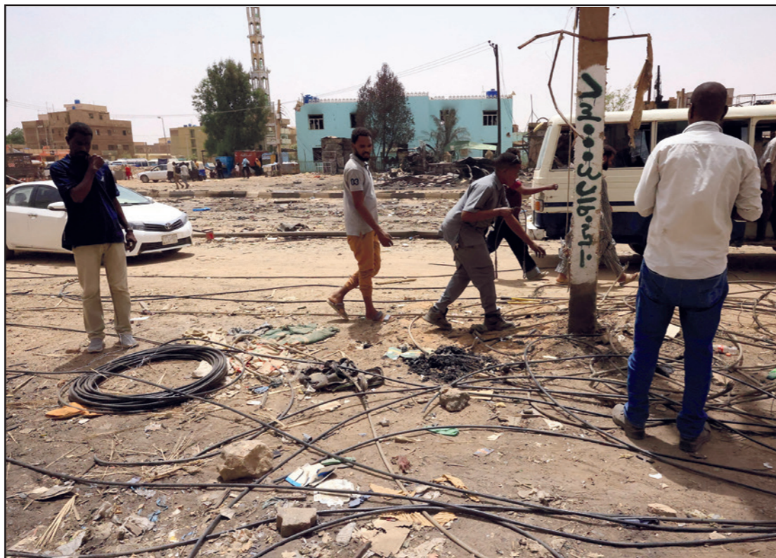
عمال يعيدون تأهيل خطوط الكهرباء في السوق المركزي في الخرطوم بحري
